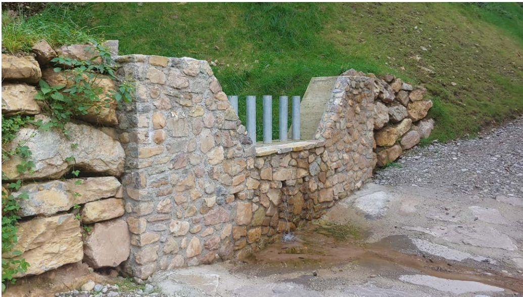
Immagine tipologica della briglia a pettine rivestita in pietrame
